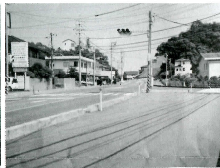
▲錦見8丁目、帝人岩国事業所水源地、道路拡幅・側溝工事等。
