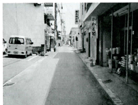
▲岩国2丁目4番地内、アスファルト・側溝工事。
