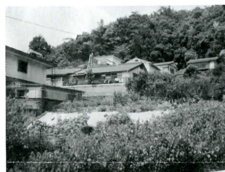
▲錦見1丁目17番地そば、急傾斜・側溝工事。
