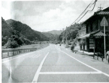
▲柱野・思案橋の所から柱野駅方向に道の整備を行っています。
