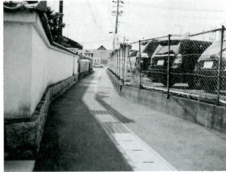
▲錦見1丁目6番地、山口トヨタそば、側溝・アスファルト工事。
